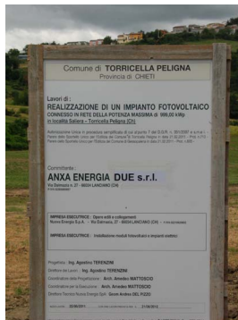
Il cartello dei lavori posto all'ingresso del terreno
