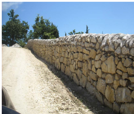
Il muro di recinzione in pietra del Monastero, attualmente in costruzione,
